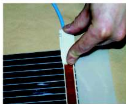
Zacisnięty konektor należy umieścić w zakrywcze plastikowej
