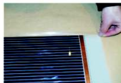
I wariant - izolować tylko paski miedziane II wariant - izolować całą linię cięcia folii
