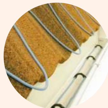
Instal. przeciwołodziowa dachu i rynny
